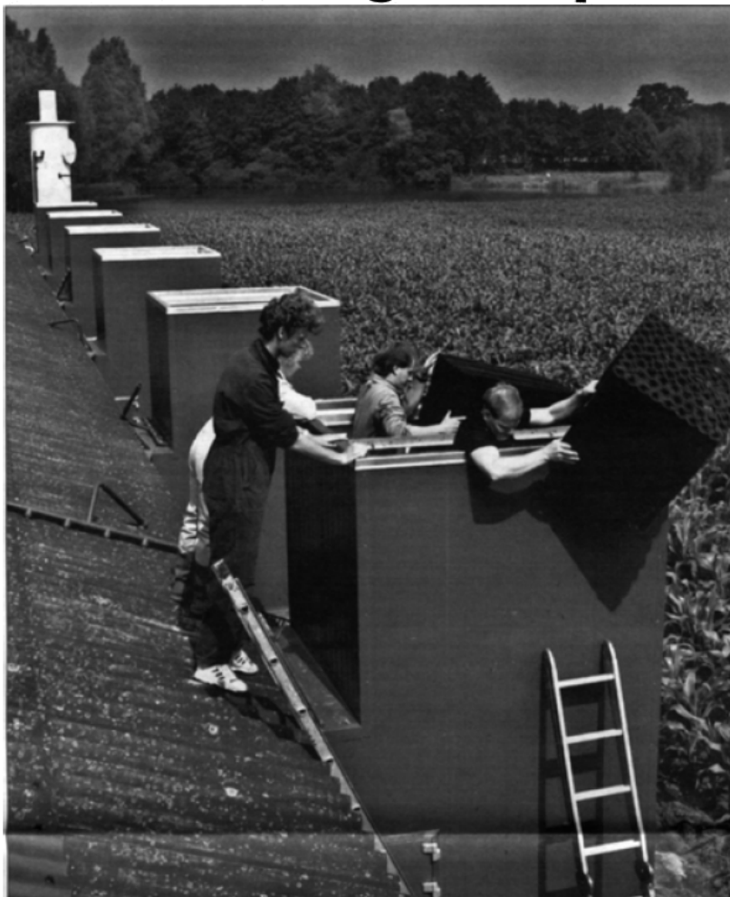
Archieffoto van een stal met luchtwassers. De wassers verwijderen ammoniak uit ventilatielucht. Foto Marcel Bekken
